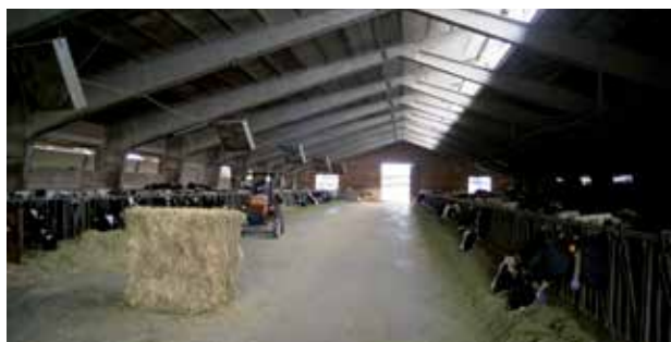
IL CORPO PRINCIPALE DELLA STALLA, COSTRUITO SECONDO LE LOGICHE DEGLI ANNI '70. SULLA DESTRA, IL "GRUPPONE" DELLE PLURIPARE
