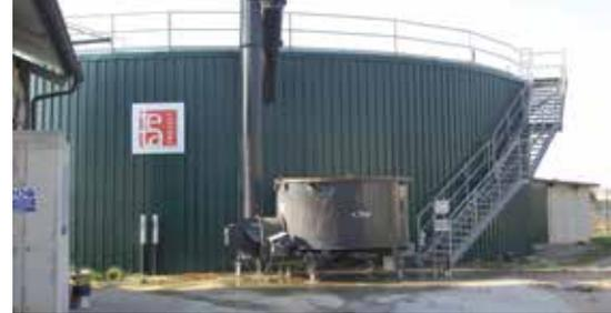
L'AZIENDA DISPONE DI IMPIANTO DI BIOGAS DA 100 KW, ALIMENTATO ESCLUSIVAMENTE CON LE DEIEZIONI DELLA STALLA. OLTRE A PRODURRE ENERGIA ELETTRICA, L'IMPIANTO RIFORNISCE LA CASCINA E LA STALLA DI ACQUA CALDA
